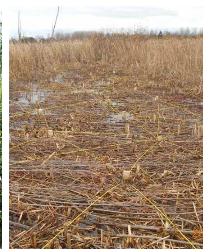
COUPE ET MISE EN PLACE DE LITS DE BRANCHES DE SAULES.
